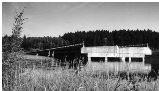
Nedokončený most dálnice D 1.
